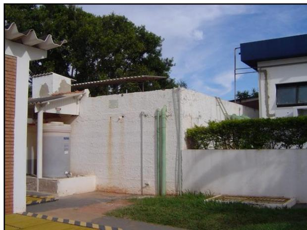
Imagem 04 - Reservatório semi enterrado de 260m<sup>3</sup>
